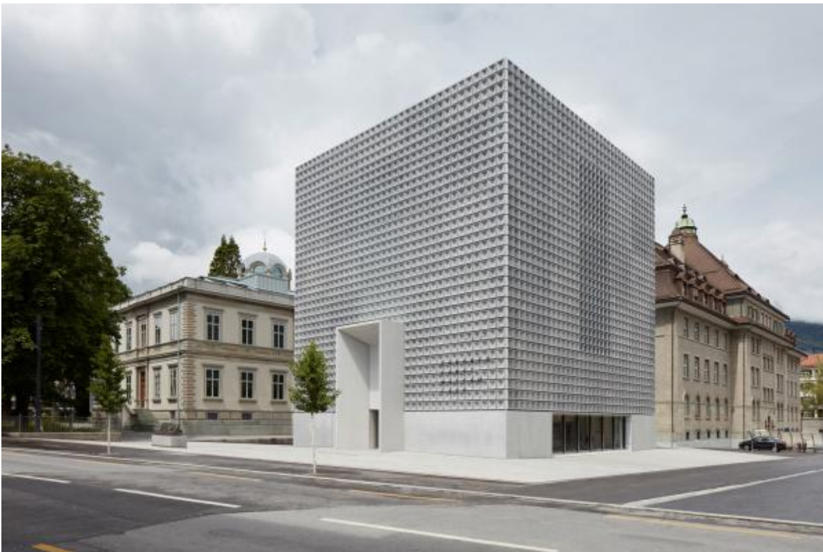
Erweiterung Bündner Kunstmuseum, Chur, Foto: Hochbauamt Graubünden.
