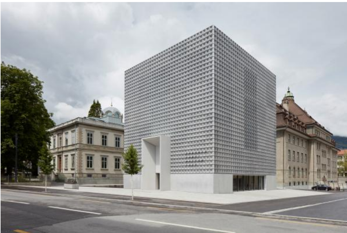
Erweiterung Bündner Kunstmuseum, Chur, Foto: Hochbauamt Graubünden.
